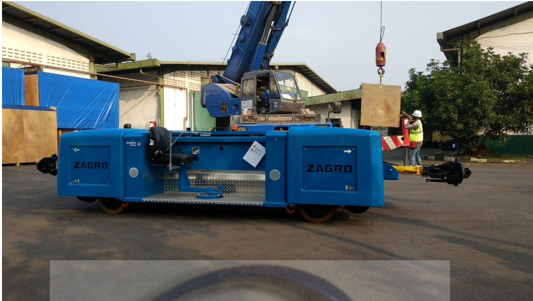
Gambar 5. 2 Material Handling menggunakan Crane (Sumber: PT Len Industri, 2018)
