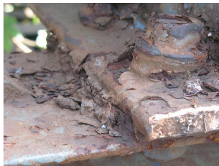
Gambar 2.5.2: Korosi Adanya Tumpukan Zat pengotor.
